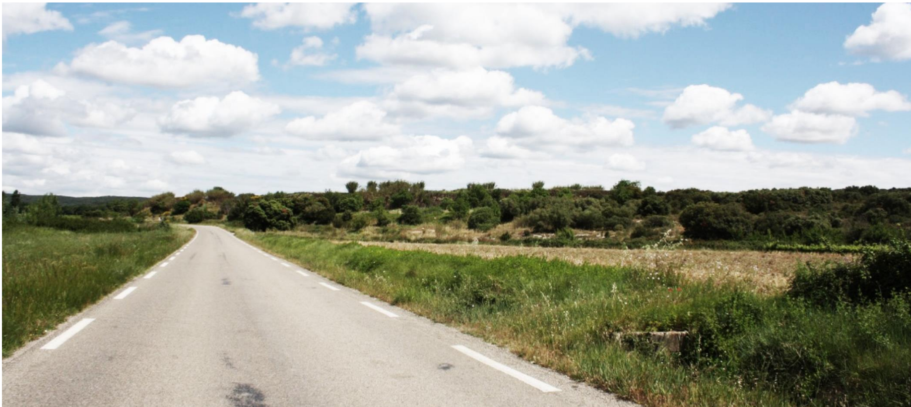
Figure 20 : Vue B - État initial (Source : WATT GROUP)
